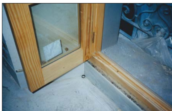
Fig. 2: Colocación de vidrio en carpintería de madera
