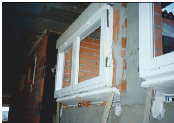
Fig. 1: Fijación de carpintería de aluminio y de vierteaguas
