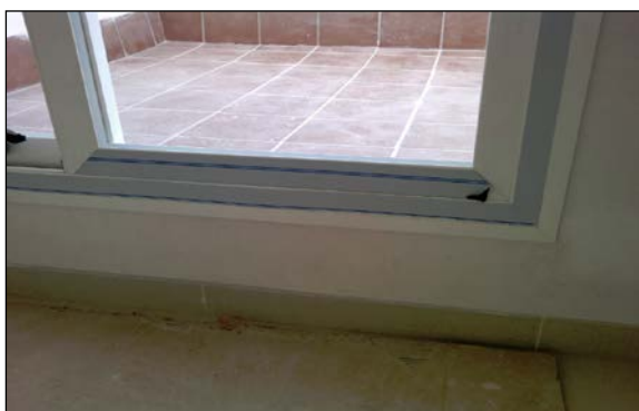
Fig. 2: Montaje de puerta corredera de acceso a una terraza
